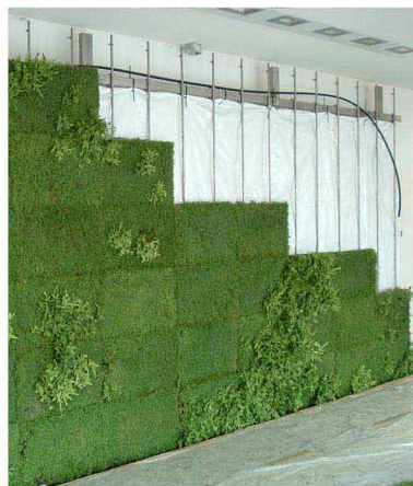
Grüne Wand im Aufbau. Green wall construction
