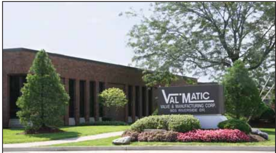
Elmhurst, IL Facility
